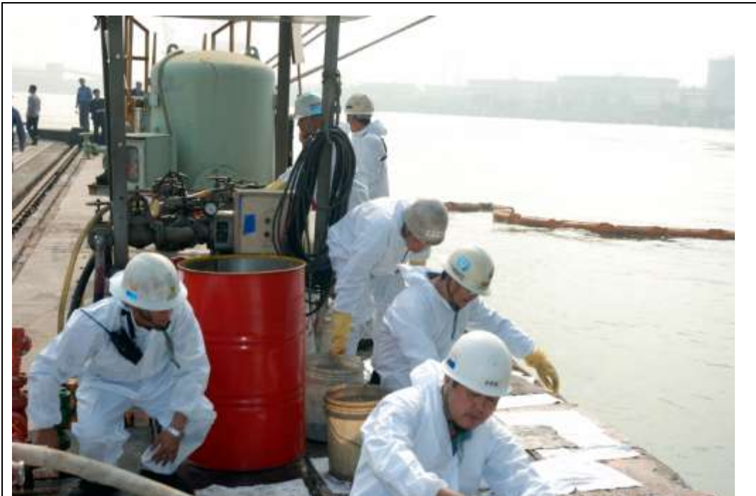
Step 11: 清潔地面油污及回收作業。
